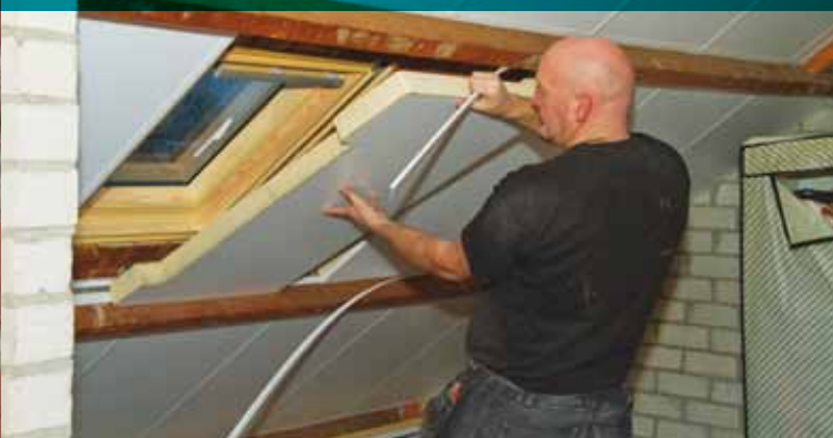
Het isoleerwerk wordt uitgevoerd door specialisten
