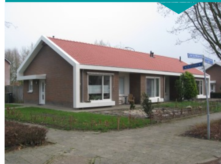
Foto's: Burg. Herkenrathlaan Ammerzoden. Situatie voor en na opwaarderen. De kwaliteit en uitstraling van de woningvoorraad is met sprongen verbeterd.
